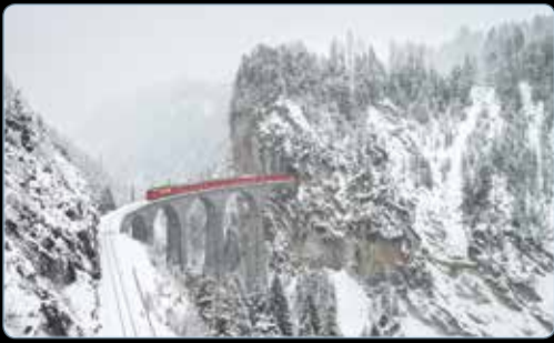
Januar Landwasserviadukt, Graubünden, Schweiz
